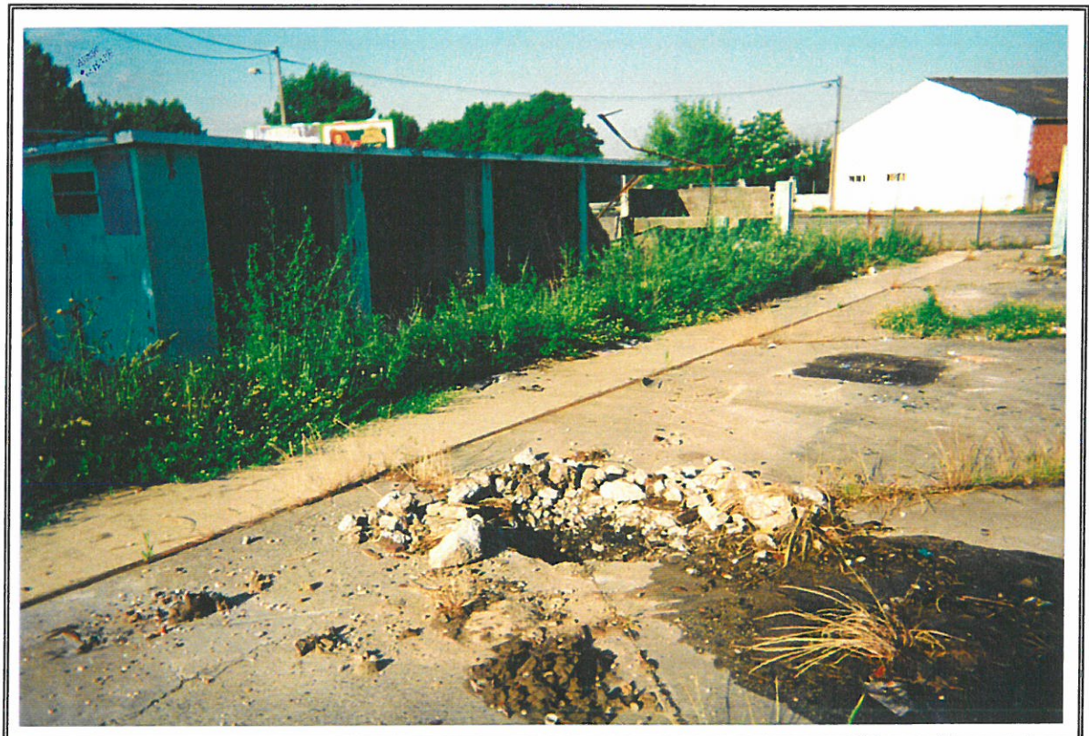
Photo 16 : Sondage 4 à proximité de la fosse de graissage
