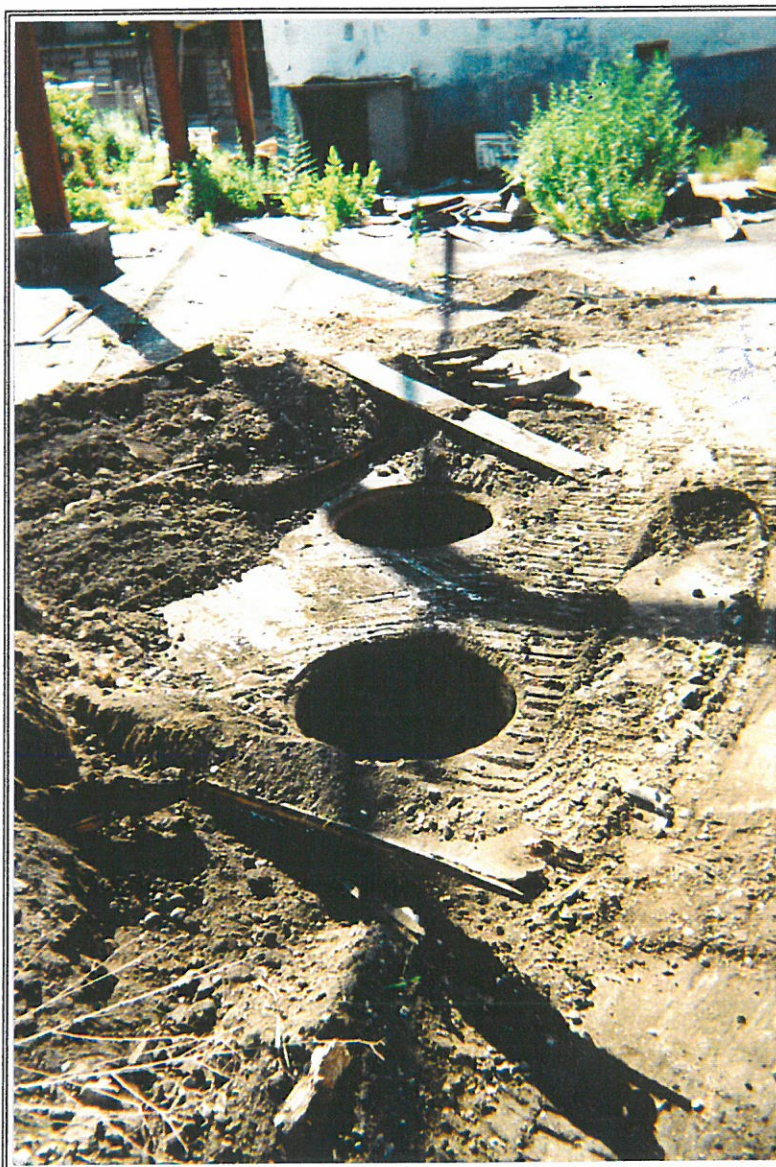
Photo12 : Découverte et ouverture des 3 bassins de décantation
