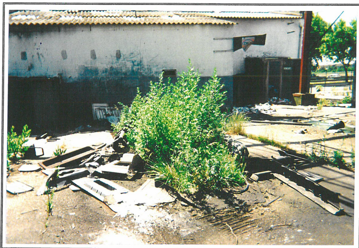
Photo 7 : Fosse de lavage de dessous de camions remblayée (avec végétation)
