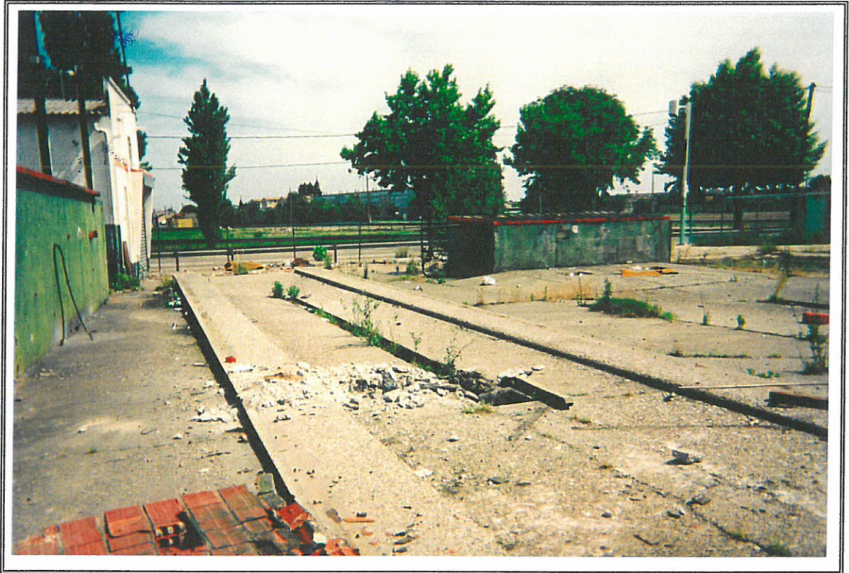
Photo 15 : Sondage 3 au niveau d'une des aires de lavage libre service
