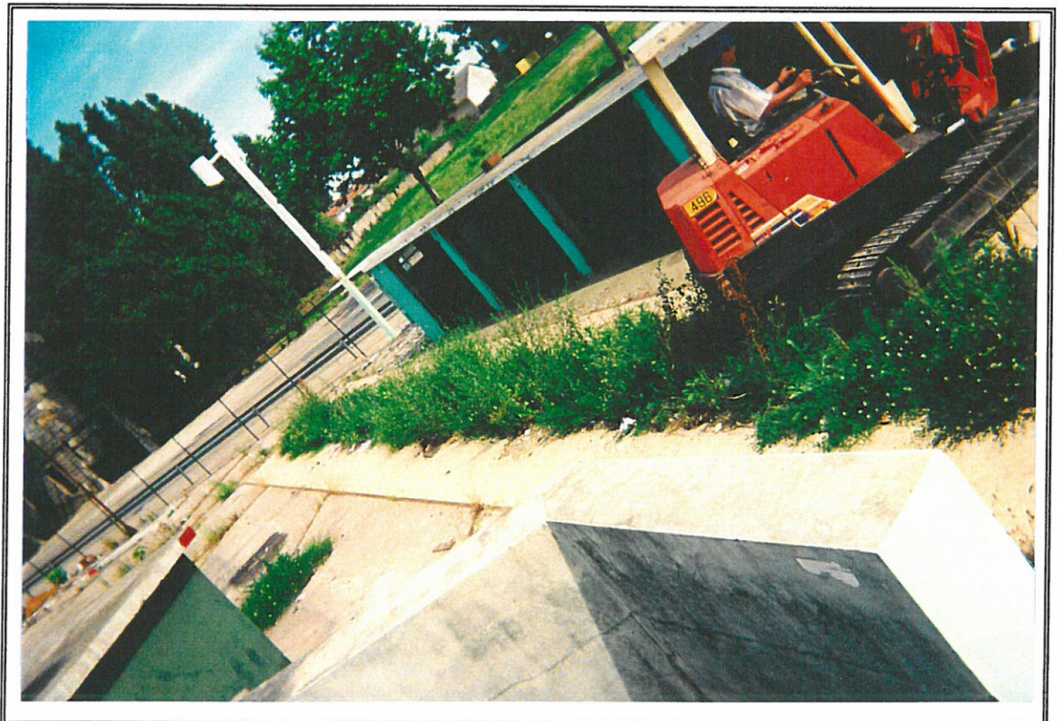
Photo 6 : Fosse de graissage remblayée
