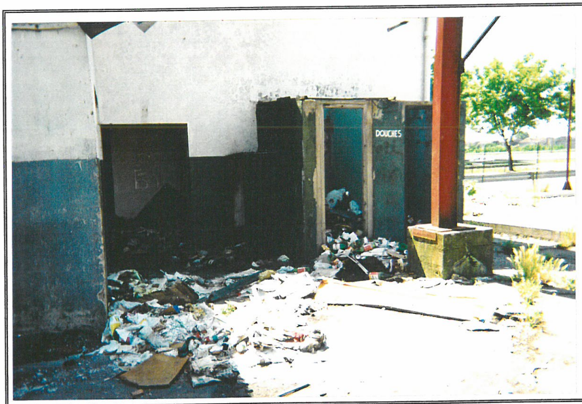
Photo 1 : Sanitaires de l'ancienne station
