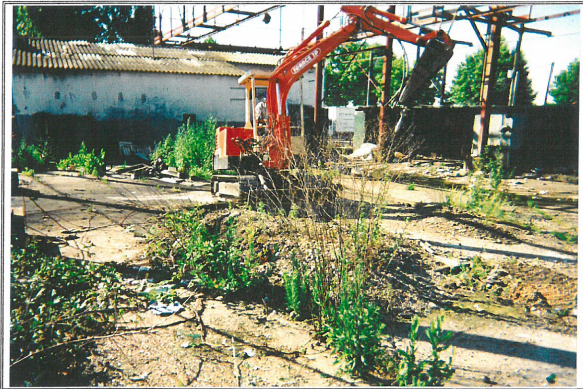
Photo 11 : Emplacement des bassins de décantation recouvert de terre avec végétation
